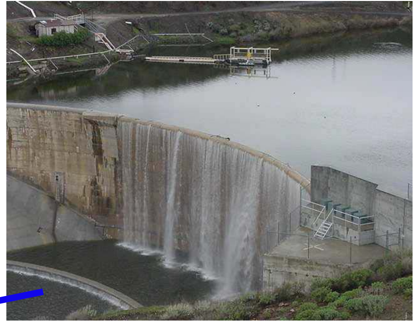
Canyon Lake Spillway
